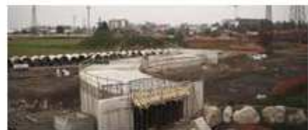
CANTIERE EXPO MILANO
